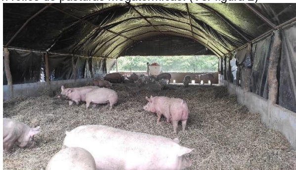
Figura 2. Galpón tipo túnel de viento techo arco.
