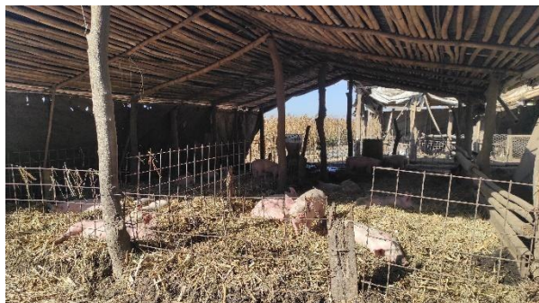
Figura 1. Galpón con cortinas laterales y techo dos aguas.
