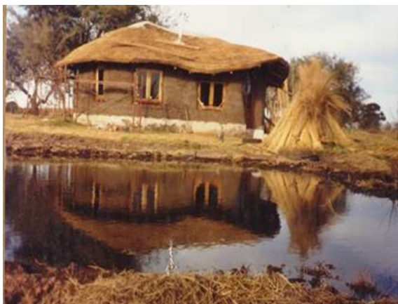
Imagen 22: casa confeccionada con técnicas de bioconstrucción que incluye la incorporación de un estanque plurifuncional (INFOBAN 2007).
