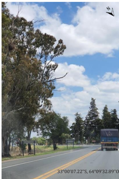
Foto 4: Falta guardarrail y árboles muy próximos a la carpeta asfáltica. Fuente: captura propia, realizada el 24/10/2022.
