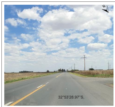
Foto 8. Falta de señalización horizontal lateral de la carpeta asfáltica. Caminos secundarios sin señalizar. Alcantarillas cubiertas de pastizales. Fuente: captura propia, realizada el 24/10/2022.
