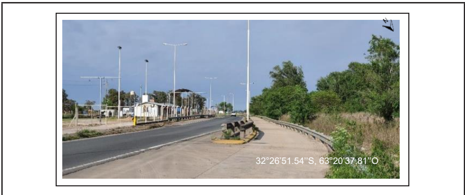
Foto 15: Balanza de Vialidad Nacional. Carriles estrechos para circulación en curva y contracurva. Fuente: captura propia, realizada el 24/10/2022.
