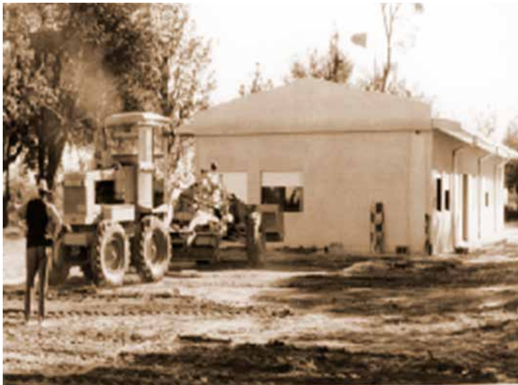
1984. Obras en el Pabellón A del viejo rectorado
