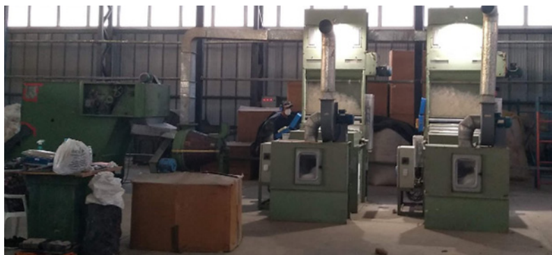
Figura 4: Equipo AM2 de descordado instalado
