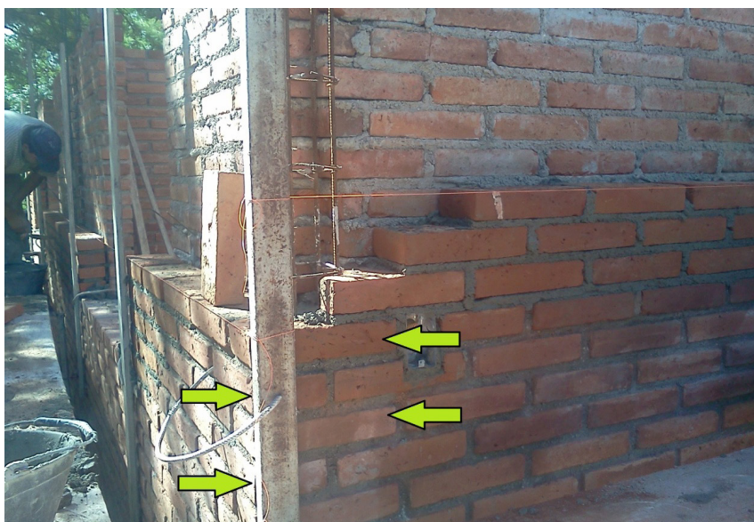
Figura 26. Trabas de los ladrillos en paredes transversales
