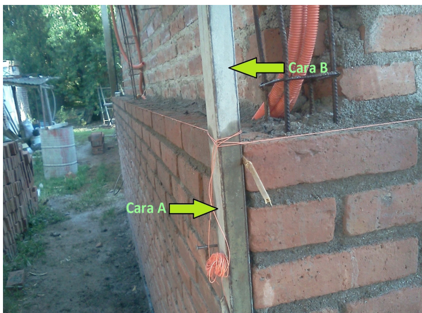
Figura 18. Regla en esquina de pared con hilos guía
