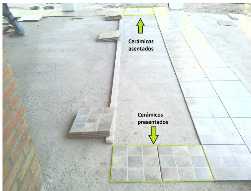
Figura 7. Reglas colocadas para iniciar una nueva hilera
