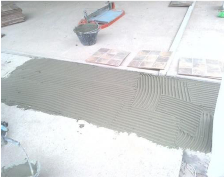
Figura 5. Reglas en escuadra y pegamento extendido sobre el piso
