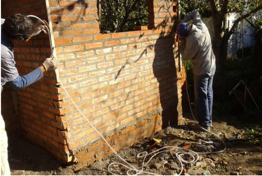
Figura 20. Utilización de manguera de nivel.
