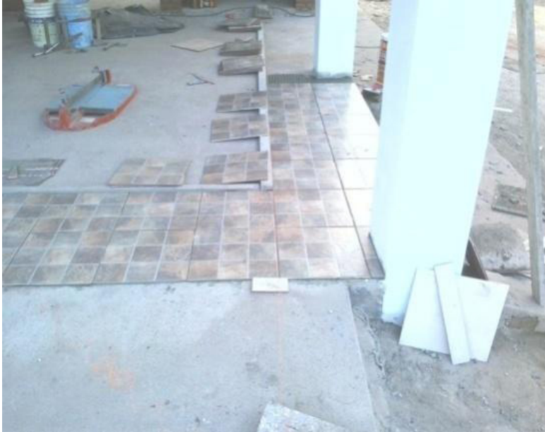
Figura 6. Hileras de cerámicos hacia el borde exterior del ambiente
