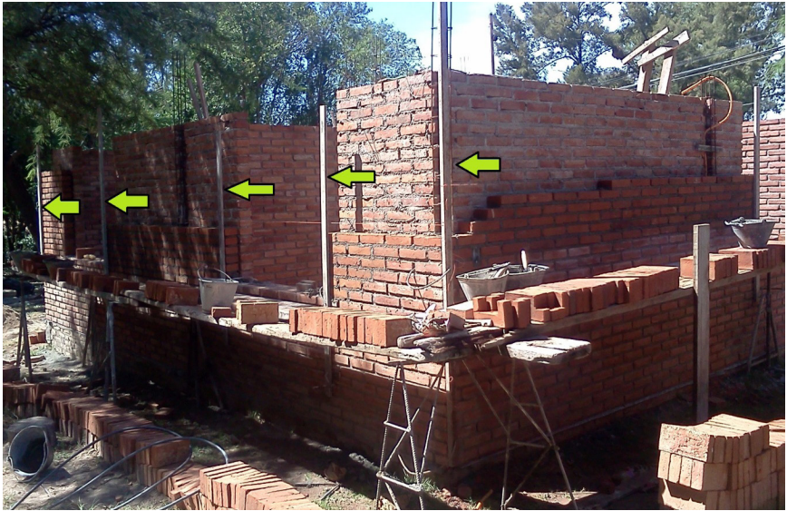
Figura 17. Vista general de dos paredes de ladrillo visto con reglas colocadas
