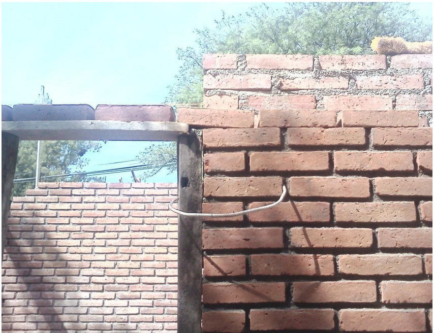
Figura 27. Traba de ladrillos en una abertura y dintel
