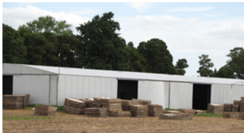
Figura 4.6. Edificio de secado y acopio.
