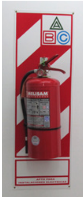
Figura 4.7. Extintor para fuegos tipos A, B y C.
